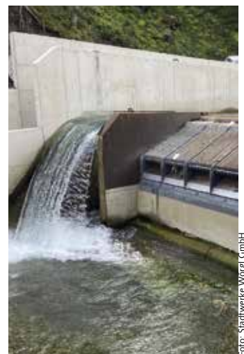
Die Restwasserabgabe erfolgt an der orographisch rechten Seite der Wasserfassung. Im Bild der wartungsarme Coanda-Rechen.
