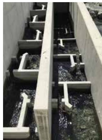
Auf einer Länge von 60 Metern überwinden die Fische mit der Fischwanderhilfe rund 3,9 Höhenmeter.
